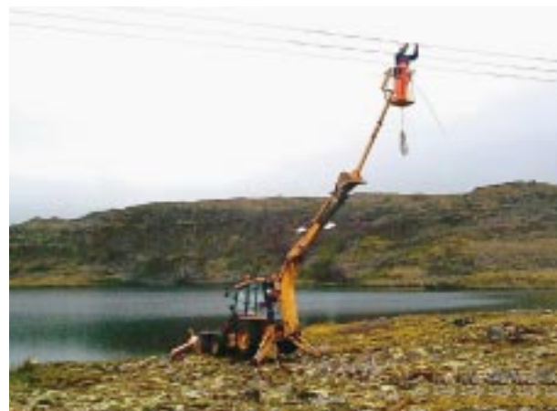
Uppsetning á vindkljúfum á Táknaarfjarðarlínu 1.
