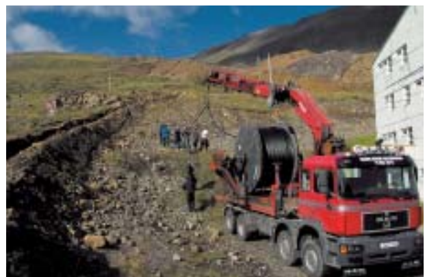
72 kV strengur dregin út á Ísafirði.
