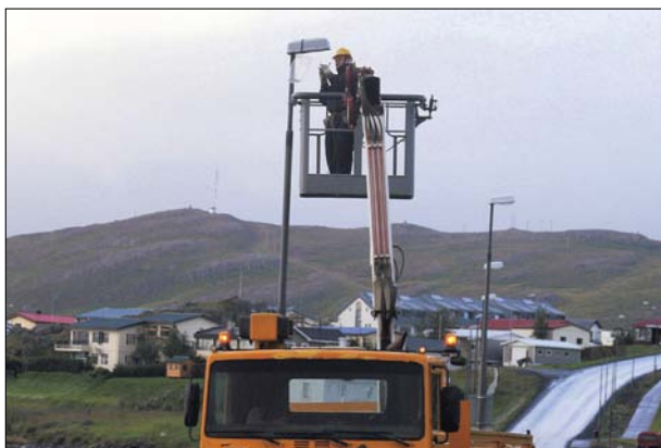
Unnið við götuljósaviðgerðir á Hólmavík
