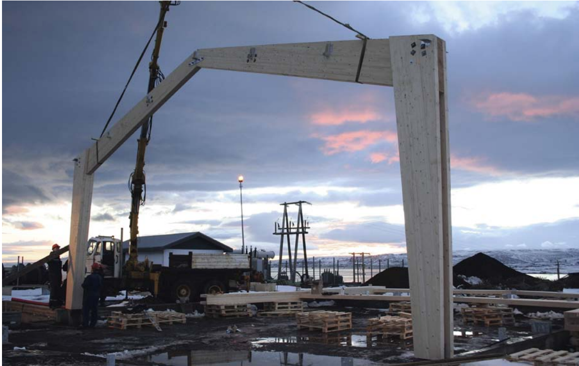
Bygging verkstæðishúss á Hólmavík
