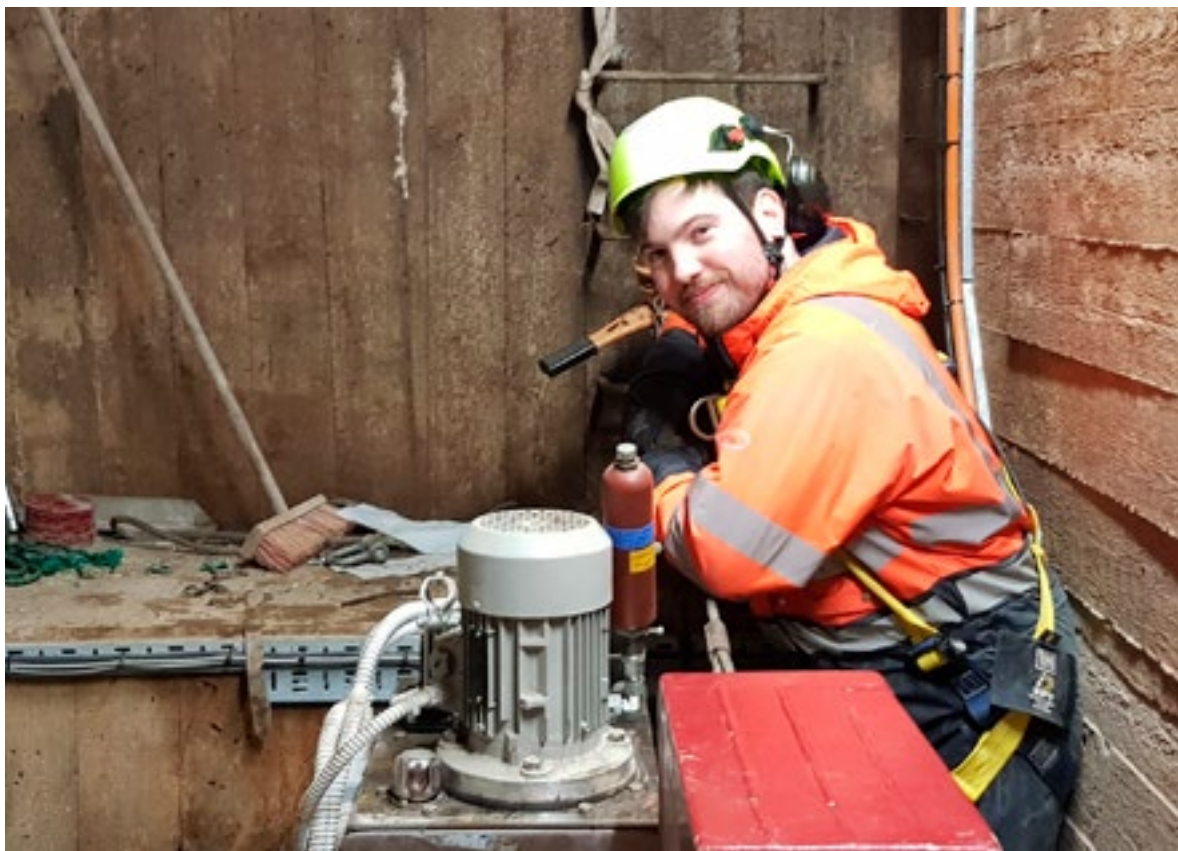
Unnið við tengingar í inntakshúsinu við Fossavatn.
