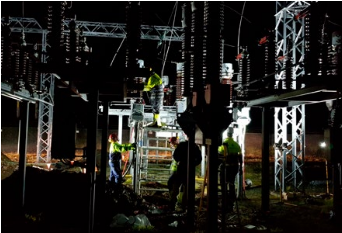
Unnið að spennuhækkun í spennivirkinu á Keldeyri í Tálknafirði.
