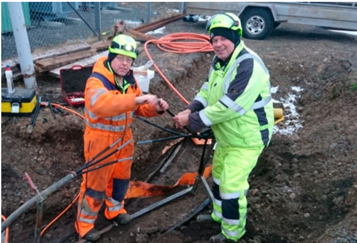
Starfsmenn á Hólmavík setja saman streng sem kemur í stað fyrstu línunnar sem reist var frá Þverárvíkjun árið 1953.
