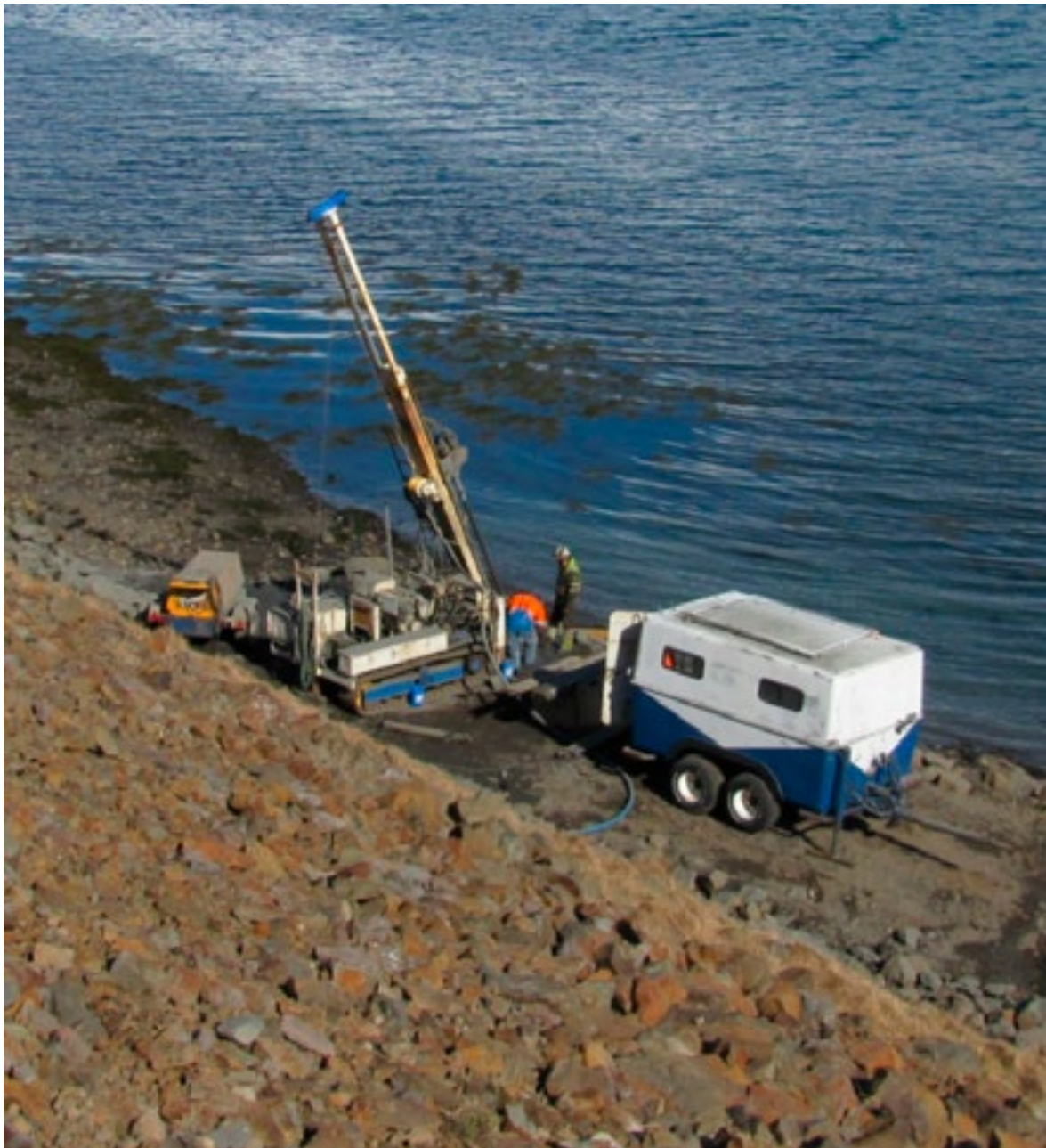
Mynd 3. Borinn staðsettur niður við sjó að bora LA-9, skáhallt undir sjóinn.
