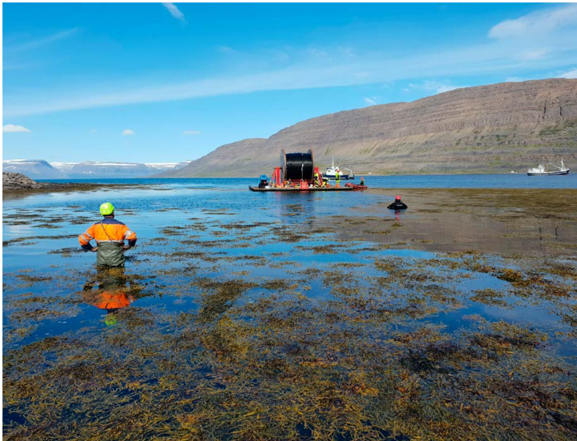
Við Hvítanes í Skötufirði. Lagning sæstrengs yfir að Skarðseyri.
