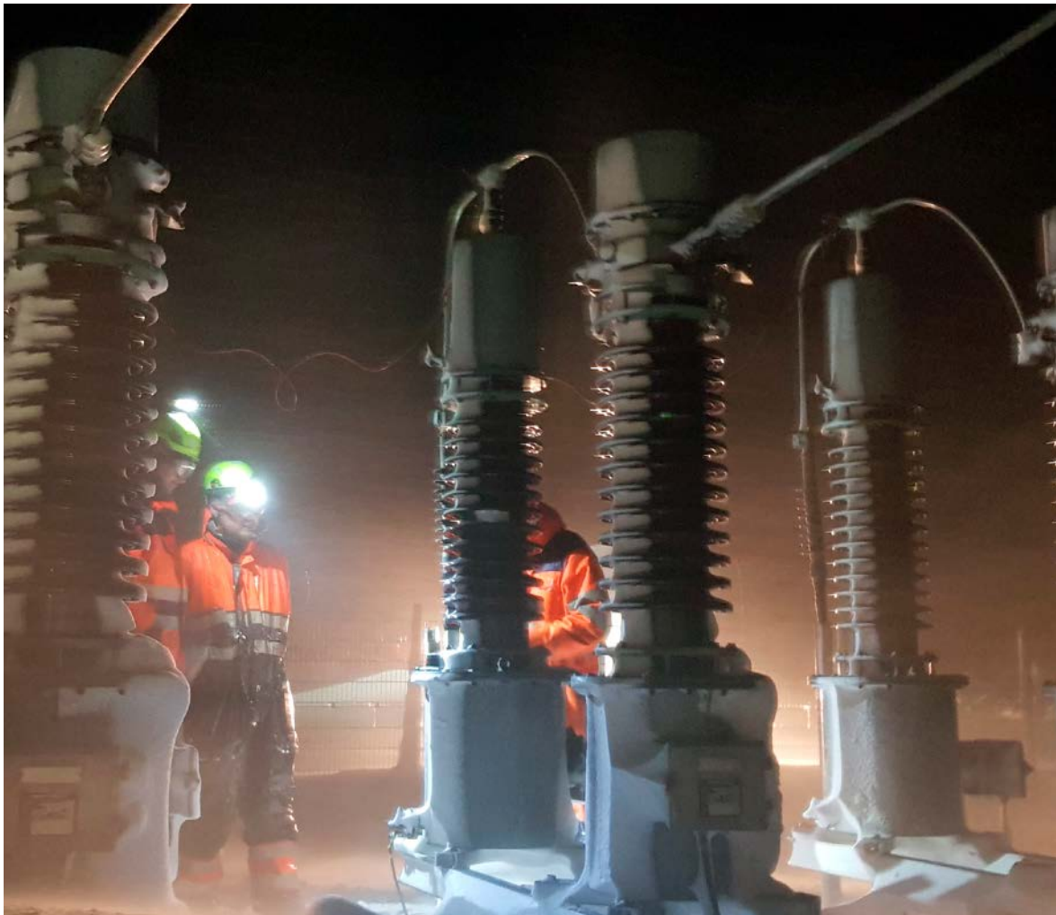
Starfsmenn hreinsa snjó og ísingu af spennu í tengivirki í Breiðadal í Önundarfirði.
