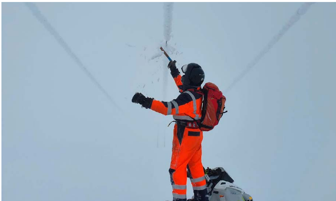
Starfsmaður hreinsar ísingu af Súðarvíkurlínu milli Engidals og Álfafjarðar.
