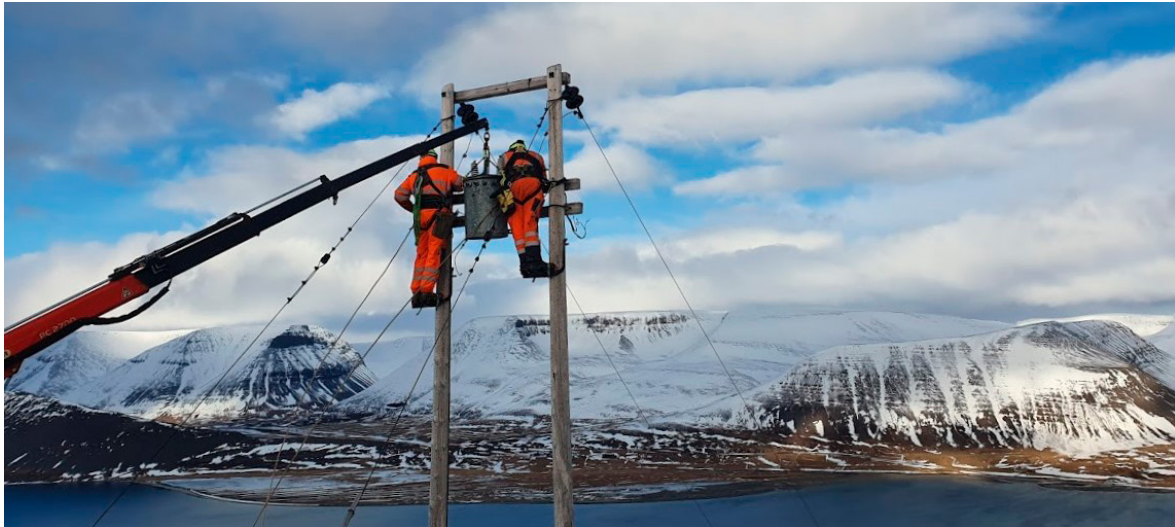
Á Sandafelli fyrir ofan Þingeyri.
