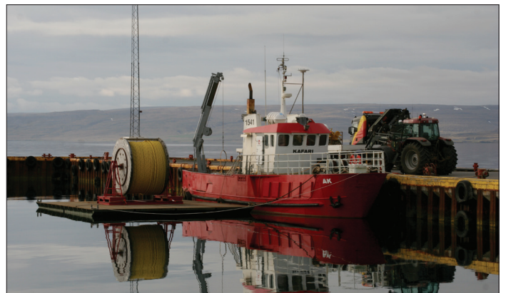
Sæstrengslögn undirbúin
