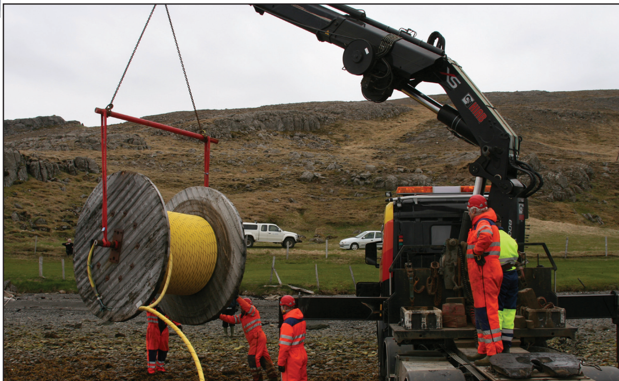
Sæstrengslögn Steingrímsfirði
