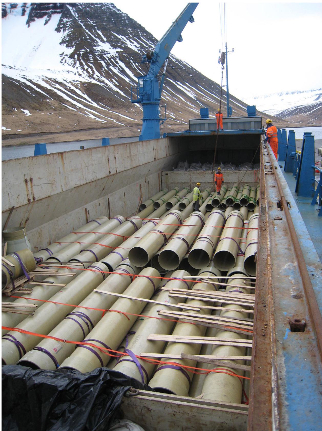
Pípa Fossárvirkjunar komin til Ísafjarðar
